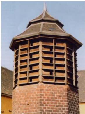
Bild 2: Das Neichener Taubenhäuser ist ebenfalls unbewohnt.
